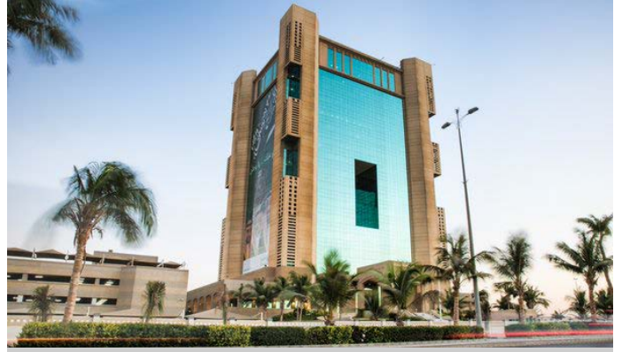
مبنى أمانة محافظة جدة
